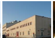
Data Center Rue du Port, 92000 Nanterre
