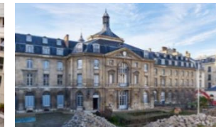
37-39, rue de Bellechasse and 104, rue de Grenelle 75007 Paris 12,500 sqm
