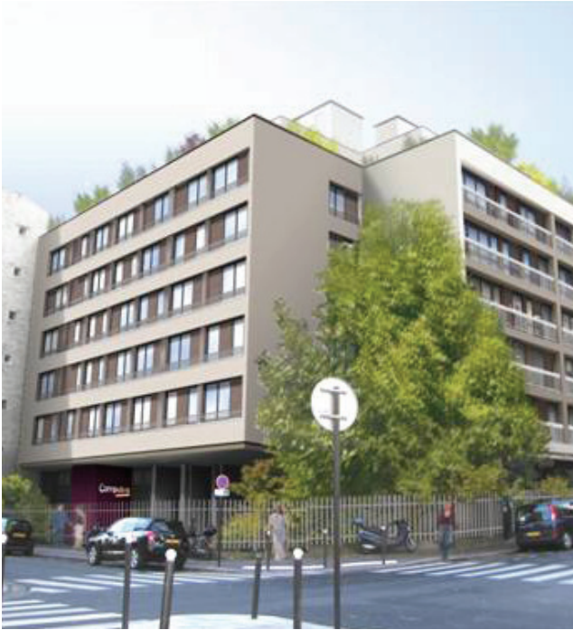
Projet rue Lançon, PARIS (13 e )
