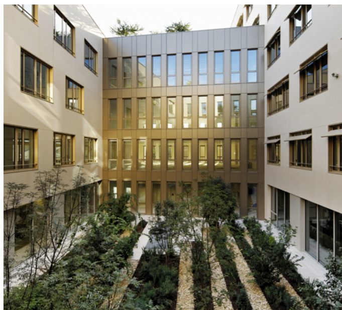
Immeuble Newside, La Garenne-Colombes.
