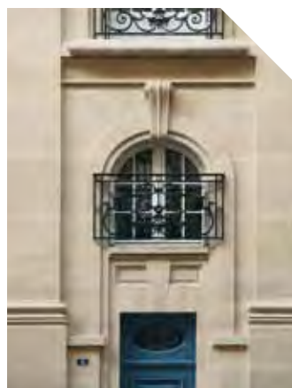
4, rue de Lasteyrie - Paris 16 e ➤
