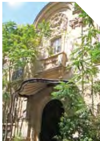
4, rue de Lasteyrie - Paris 16 e ▲
