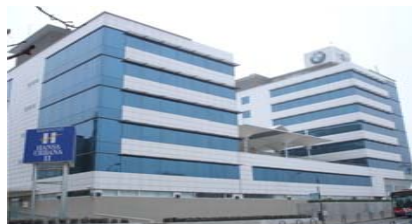
Immeuble BMW (Madrid) Investissement: 59 M€ 12 000 m 2 Construit en 2004 Locataire BMW jusqu'en 2014
