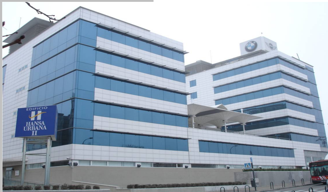
Immeuble BMW (Madrid) 12 000 m 2
