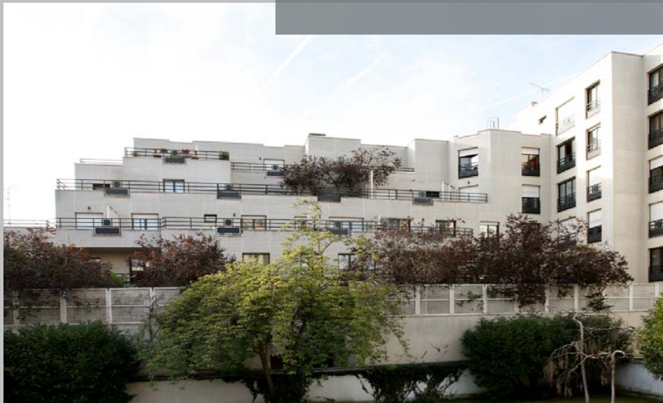
Boulevard Jean Jaurès - Boulogne (92) 49 logements
